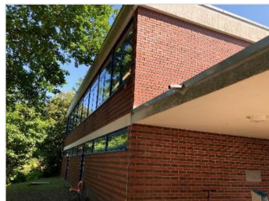
Wasserspeier direkt über dem Haupteingang (Fotos: Rechnungshof, Juni 2023)
