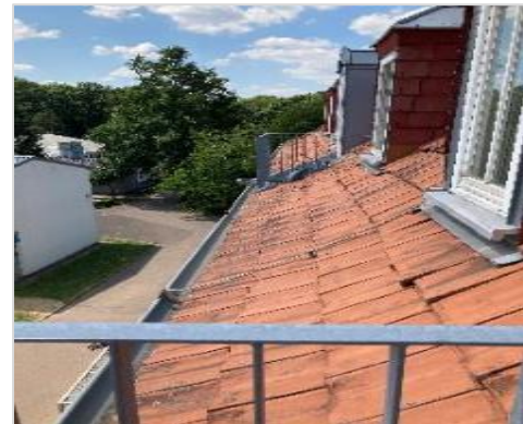
Enge Fluchttüren mit Fluchtbalkonen aus der Aula im Dachgeschoss – drei Geschosse über dem Schulhofniveau (Fotos: Rechnungshof, Januar 2023)
