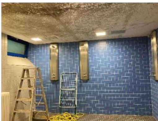
Schimmelpilzbildung in Umkleiden und Duschen (Fotos: Rechnungshof, Juni 2023)
