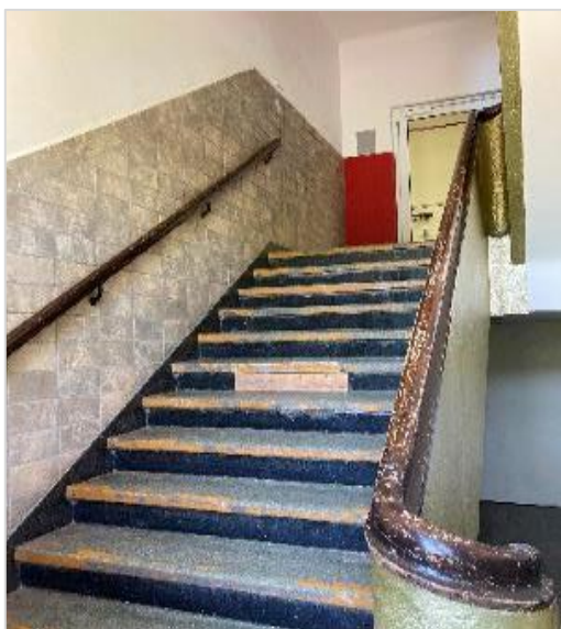
Sanierung des Haupttreppenhauses: Defekte Stufen mit Holzbrettern kaschiert, Treppengeländer golden gestrichen, Ausbesserung des Bodens im Haupteingang des Mehrfachbehindertenbereichs mit Panzerband (Fotos: Rechnungshof, Mai 2023)
