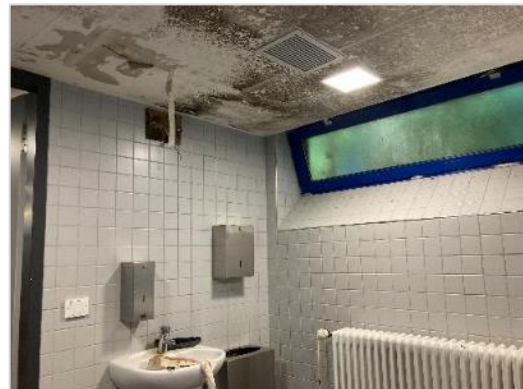
Schimmelpilzbildung in Umkleiden und Duschen (Fotos: Rechnungshof, Juni 2023)
