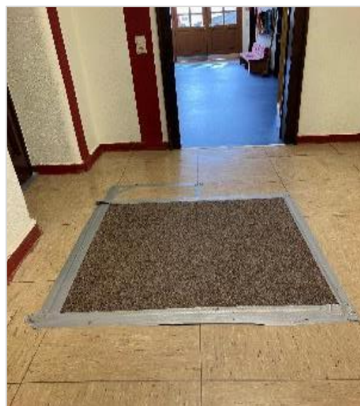
Sanierung des Haupttreppenhauses: Defekte Stufen mit Holzbrettern kaschiert, Treppengeländer golden gestrichen, Ausbesserung des Bodens im Haupteingang des Mehrfachbehindertenbereichs mit Panzerband (Fotos: Rechnungshof, Mai 2023)
